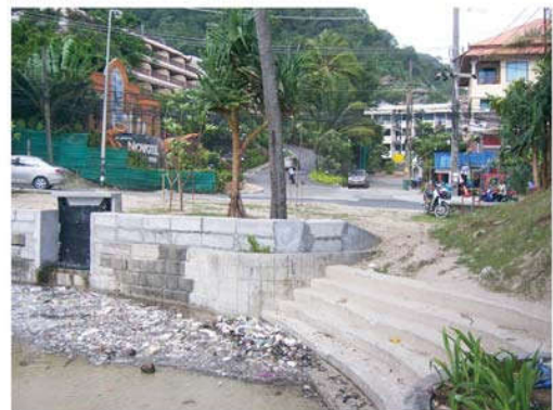
วางท่อระบายน้ำ ลงสู่ทะเลเสร็จเรียบร้อย ปลายท่อมีประตูเปิด - ปิด กันน้ำทะเลไหลเข้าเมื่อน้ำขึ้น
