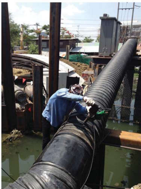
▶ โครงการอุโมงค์ส่งน้ำบางซื่อ กทม. ใช้เป็นท่อผันน้ำในคลองบางซื่อ กทม. ขนาดท่อ 600 mm.
