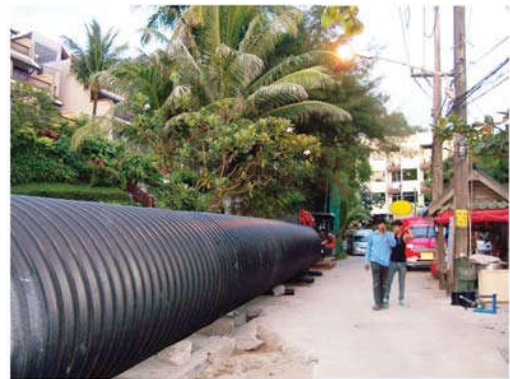
เชื่อมต่อทุกจุดเรียบร้อย เตรียมนำไปวาง
