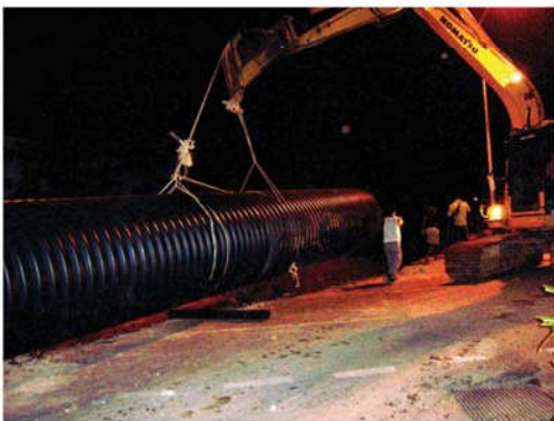
ยกวางทั้งเส้นอย่างง่ายดาย เนื่องจากท่อน้ำหนักเบา
