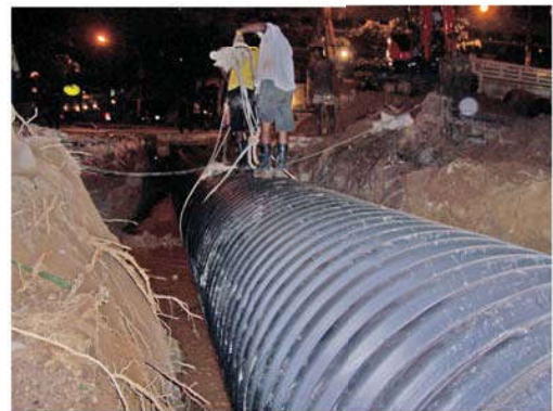
เปิดถนนไม่เกิน 2 ชั่วโมง วางท่อระบายน้ำเสร็จเรียบร้อย
