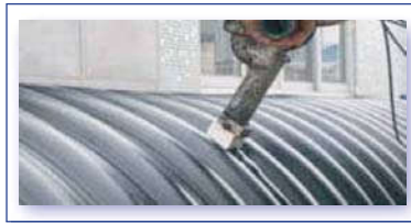
▶ ใช้ลวดเชื่อม 3.5 - 4 mm.
